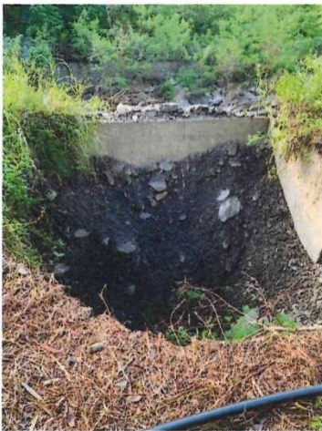
工區 1 衛星定位點：X座標 218933.00000 Y座標 2465383.00000 (TWD-97)
