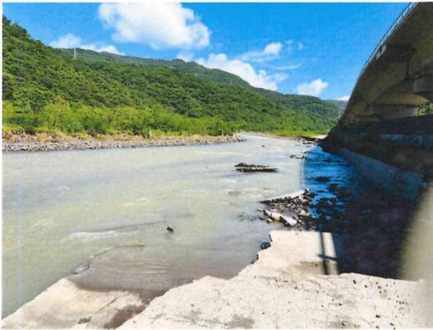
工區 1 衛星定位點：X座標 224213.00000 Y座標 2456565.00000 (TWD-97)
