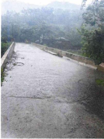
工區 1 衛星定位點：X座標 227929.26103 Y座標 2457396.24819 (TWD-97)
