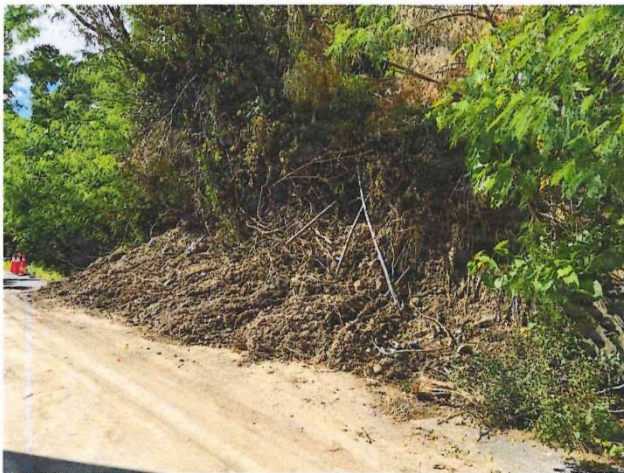
工區 1 衛星定位點：X座標 220091.75749 Y座標 2455118.19752 (TWD-97)
