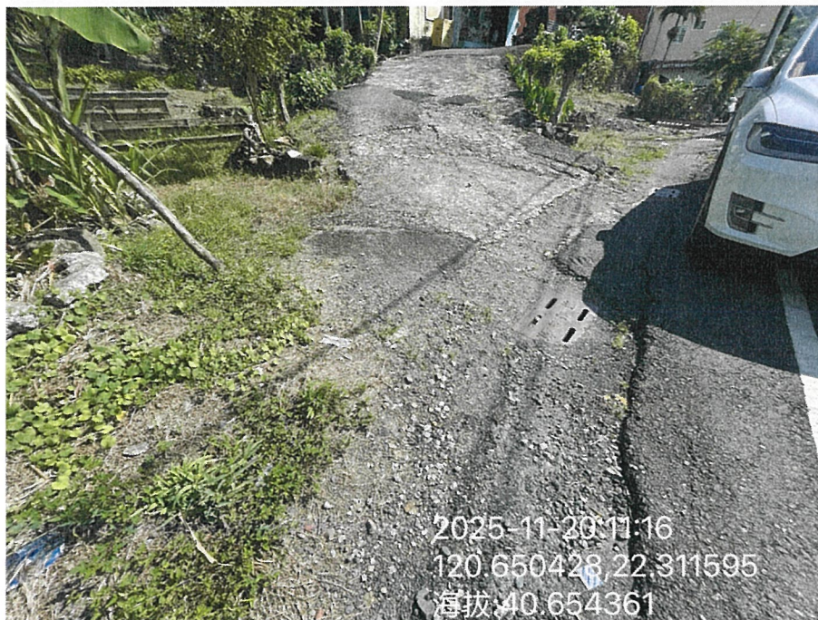
路面與側溝高低差明顯
