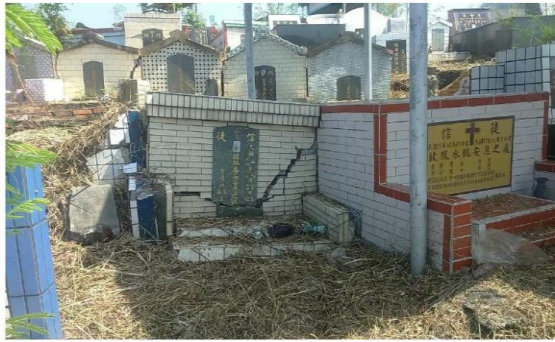
因地層滑動，擠壓墓座，造成墓座裂開，有棺木外露之虞。
