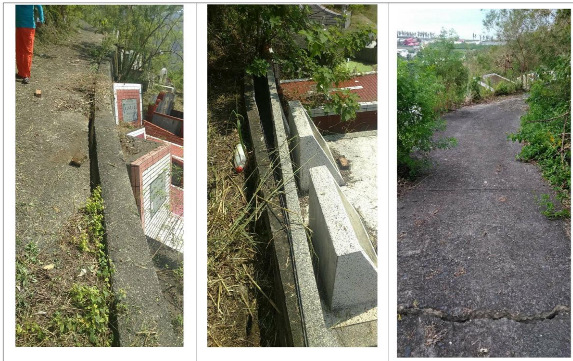
因地層滑動，擠壓基座，造成基座裂開，有棺木外露之虞。
