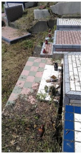
因地層滑動，擠壓墓座，造成墓座裂開，有棺木外露之虞。
