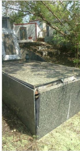
因地層滑動，擠壓墓座，造成墓座裂開，有棺木外露之虞。
